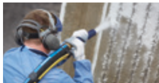
8,6 bis 10 bar: Strahlarbeiten
